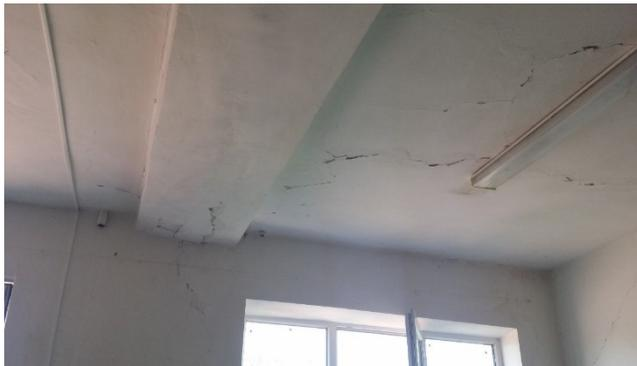
Фото 2. Трещины на потолке и стенах
