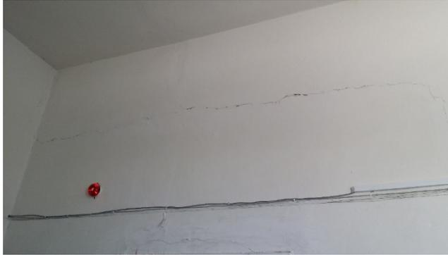
Фото 1. Трещина в стене
